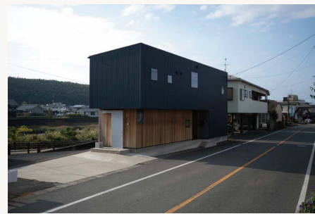
黒いガルバリウムとレッドシダーの板壁との切り替えがスタイリッシュな外観。台形の土地を活用した駐車場の配置も絶妙
