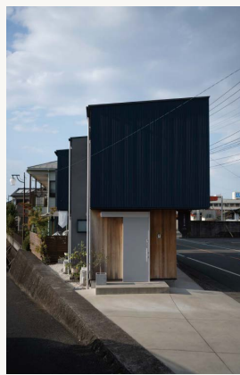
当初のプランでは事務所と住宅の玄関を1つにしていたが、暮らしのメリハリを付けるためにそれぞれ独立させることに
