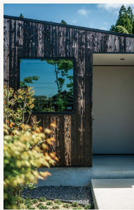
左ノインナーガレージも検討したが、広い敷地を生かし、母屋の横にガレージを設置。 右ノ外壁は焼杉を使用。風雨にさらされることで経年美化ともいえる風合いを醸し出す
