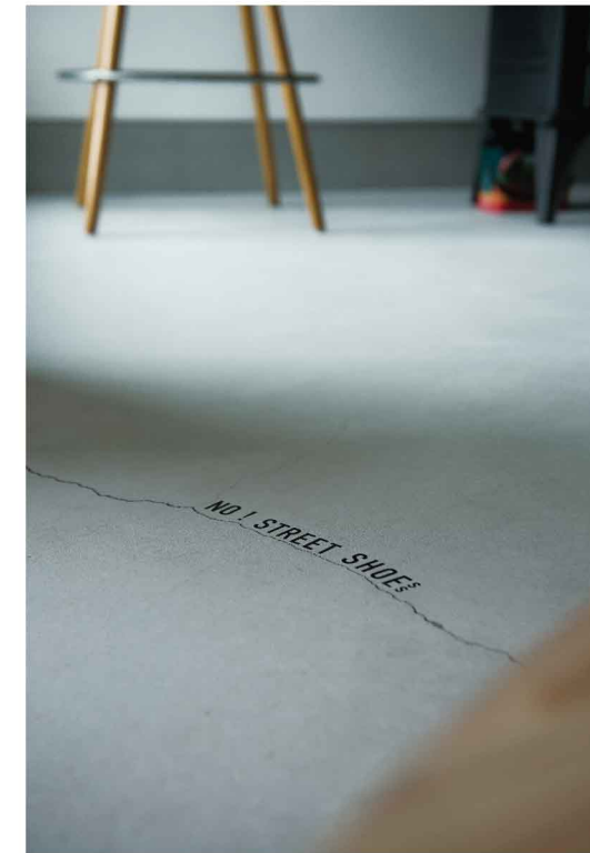
構造上問題は無いもののモルタル塗の土間は、ひびが入りやすいもの。そのひびを間仕切り利用するセンスに脱帽!
