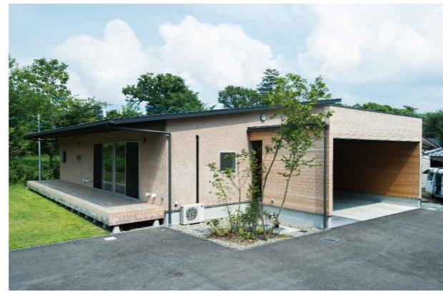
広いビルトインガレージは玄関と直結しているので、荷物や仕事道具の出し入れも便利
