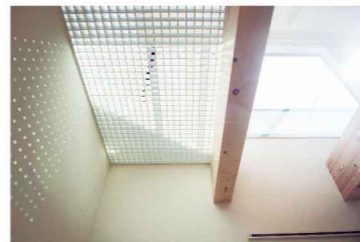
FRPグレーチングもお気に入り。まるでサンルームのように光のシャワーが降ってくる
