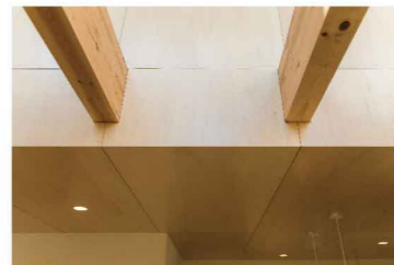
リビングの天井から吹き抜けの壁にはシナベニヤを使用。クリーンな壁天井が空間のアクセントに
